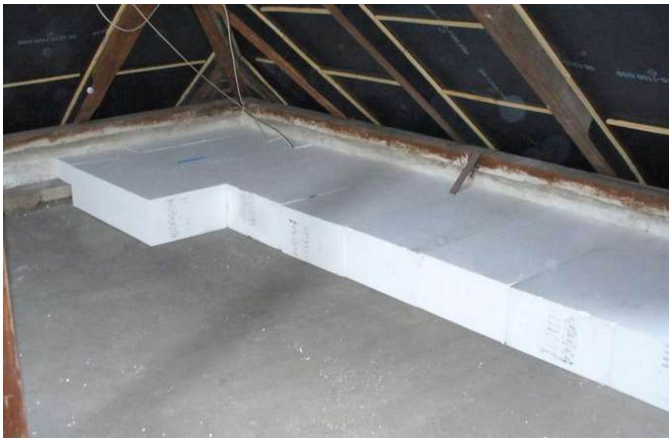
Obrázek č. 4.9.3: Zateplení stropu pěnovým polystyrenem pod nevytápěnou půdou (Zdroj: nejremeslnici.cz)
